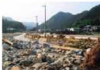
道路には川のように水が流れ(向が原地区)
