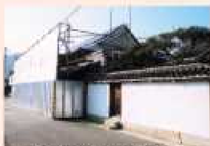
改築工事が進む引田地区の 旧商家「井筒屋」
