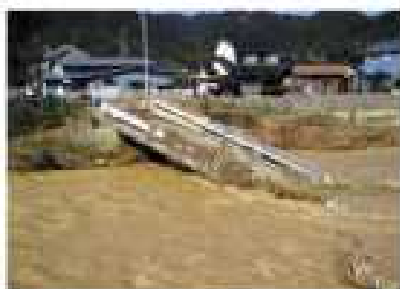
濁流に押し流された大柱下橋(大社地区)
