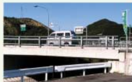
小海の南谷川にかかる橋です
