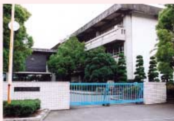
耐震補強などの工事が決まった三本松小学校校舎
