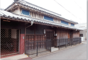
神崎家（屋号：米屋）（現大島家） 江戸初期から醤油醸造や廻船業で財をなし、引田村一の豪商でした。
