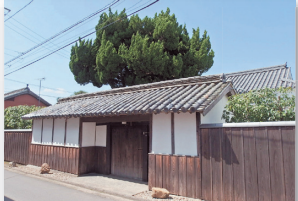
木村家 江戸時代から続く医者の家。建物は井筒屋前で醤油醸造を営んでいた四宮家（屋号花屋）から移築したものと伝えられています。
