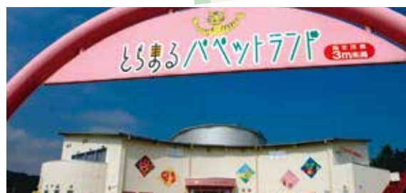
とらまる人形劇ミュージアム 空調改修工事
