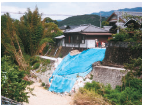
急がれる災害復旧現場
