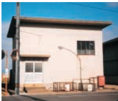
▲松東ポンプ場
