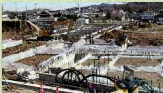
大内地区幼保一元化施設新築工事
