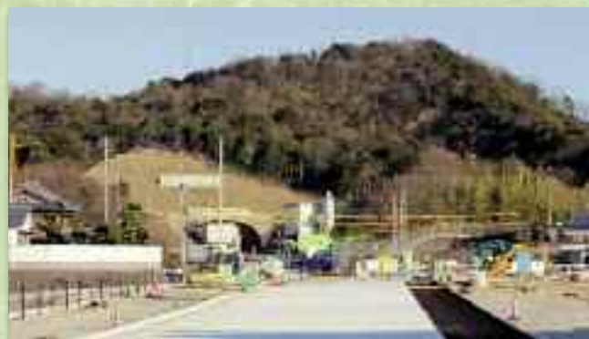
国道11号バイパス工事(前山トンネル)
