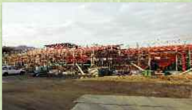
丹生コミュニティセンター（仮称）新築工事
