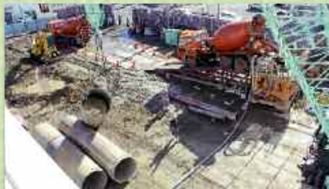
市統合庁舎建築工事
