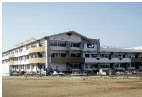
建設中の大内小学校
