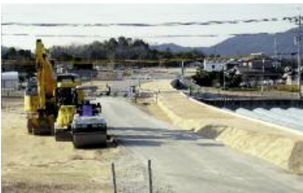
国道11号バイパス工事状況
