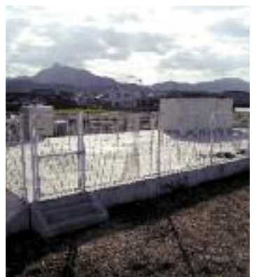
川東上地区農業集落排水処理施設
