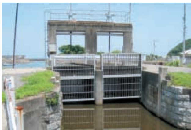
松原(引田)ポンプ設置予定地
