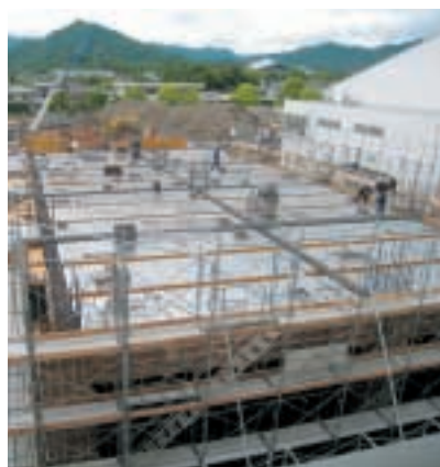
大内小学校建設工事
