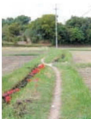
未整備の農道水路
