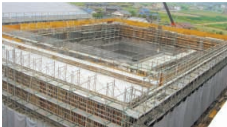
建設が進む引田中学校体育館
