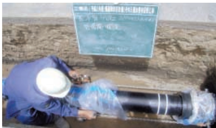
石綿管の布設替え工事
