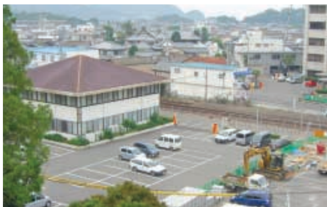
東かがわ市地域産業振興センター（東かがわ市商工会 引田支所）
