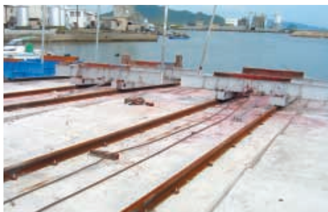
完成した三本松港船揚場
