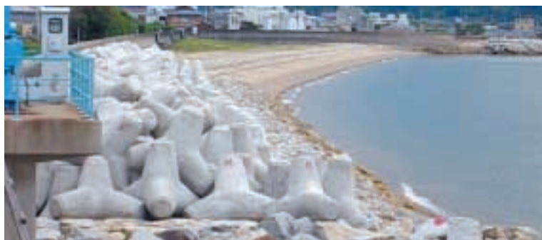
須賀地区消波ブロック設置
