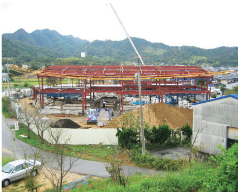
建設中の給食センター
