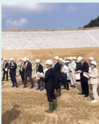
建設中の農業用ため池を視察
