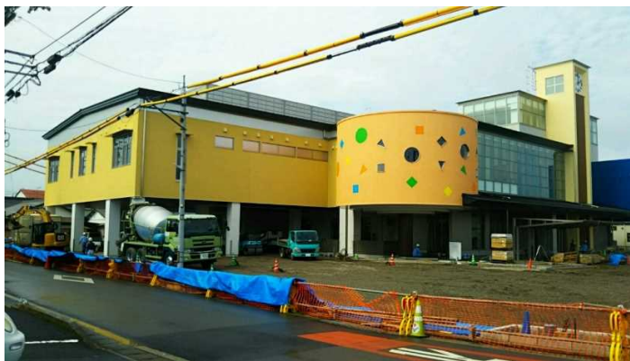
建屋は完成して外構工事中
