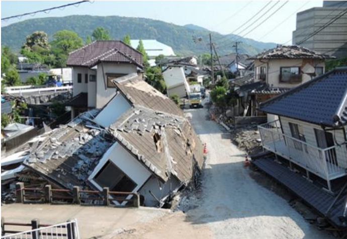
熊本地震(2016年・最大震度7)の被害状況写真
