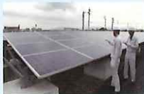
太陽光発電設備の検査の様子
