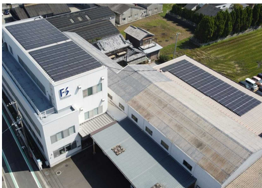
太陽光発電システムを設置している社屋屋上
