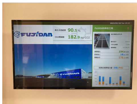
※本社工場に設置した太陽光発電システムの発電量モニターを設置
